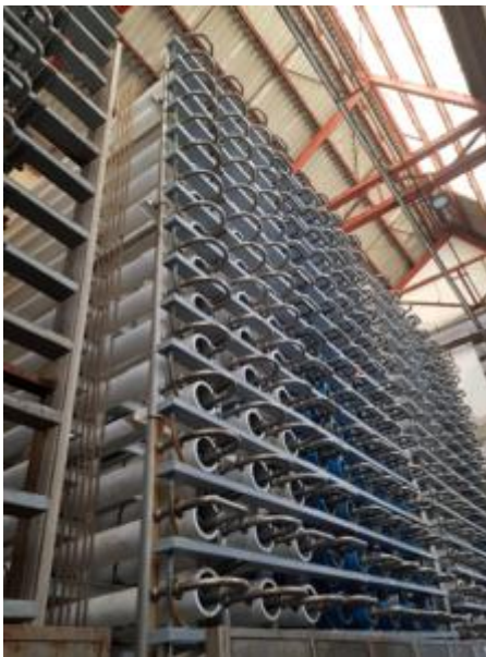
Figura 5-24 Bastidores de osmosis inversa
