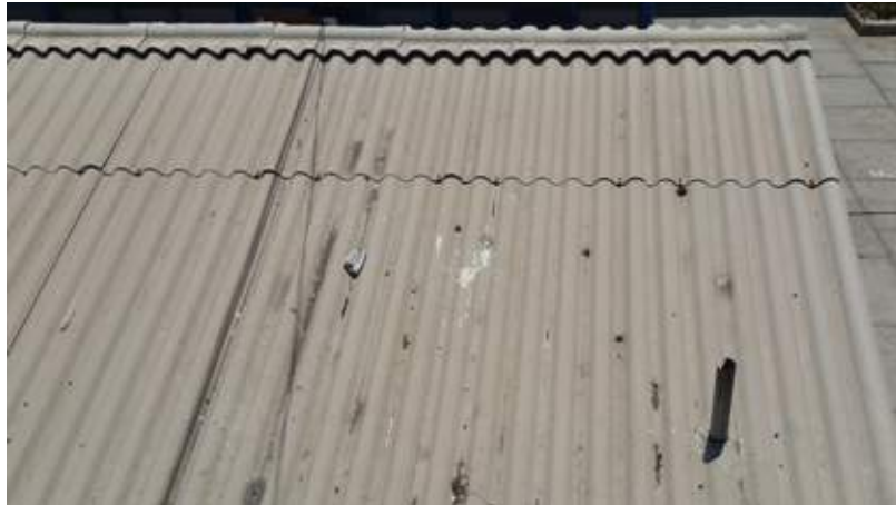
Ilustración 17 Fotografía de cubierta de pizarreño (Fuente: Ministerio de Energía)
