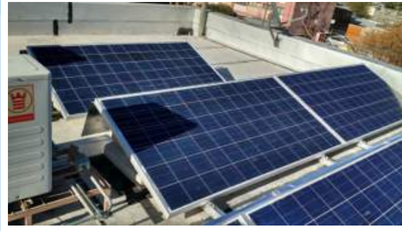
Ilustración 20 Sistema FV con sombra interna generada por un equipo de climatización (Fuente: Ministerio de Energía)
