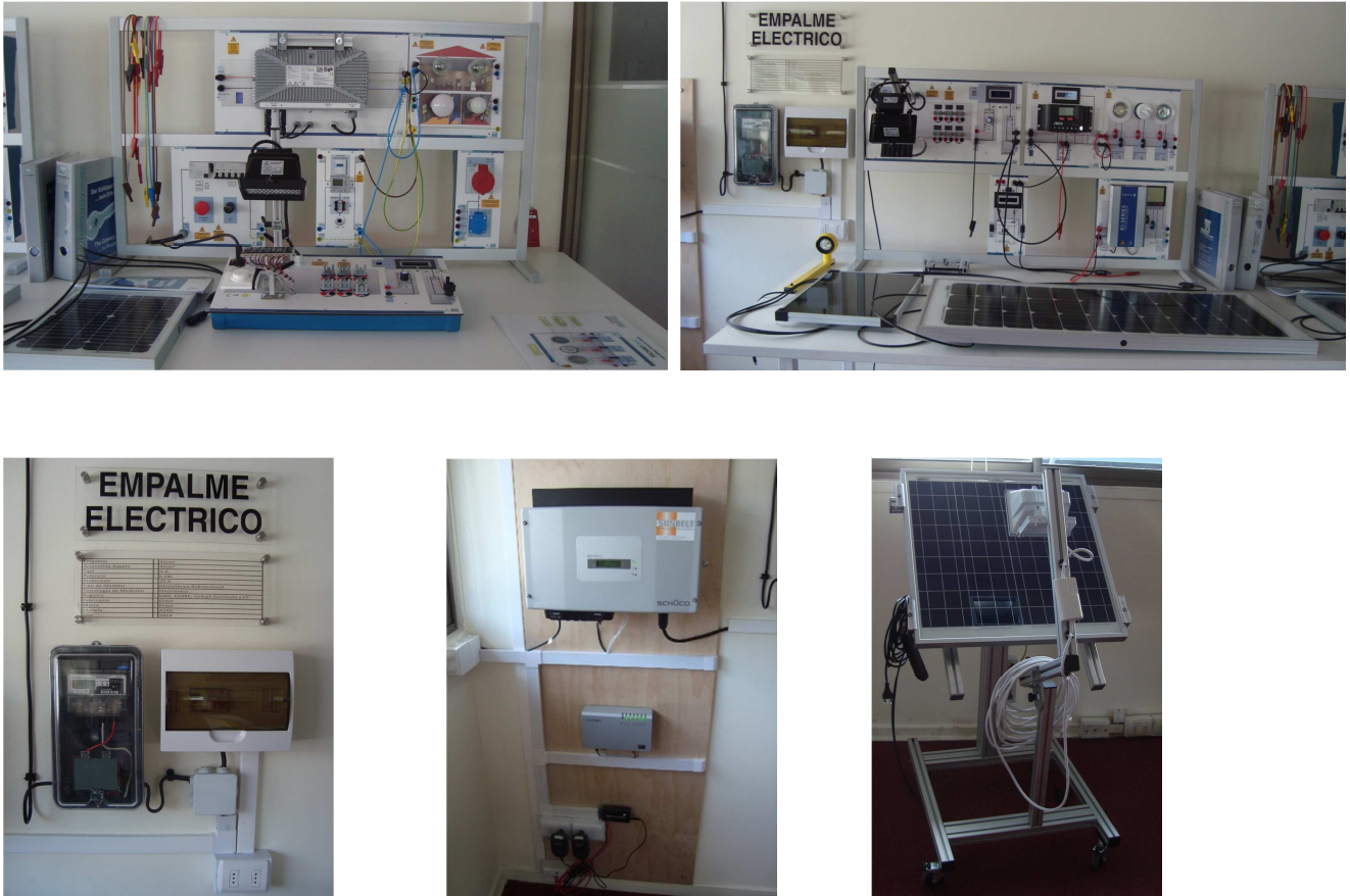
Ilustración 9: Laboratorio FV del Centro de Formación Técnica ProAndes
