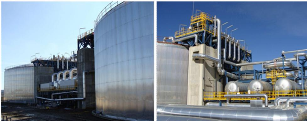
**Figura 4-10: Almacenamiento de energía con sal fundida en dos estanques<sup>35</sup>**
