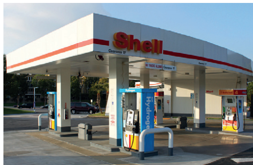
Figura 13: Estación de carga para automóviles a hidrógeno. Fuente: California Fuel Cell Partnership.
